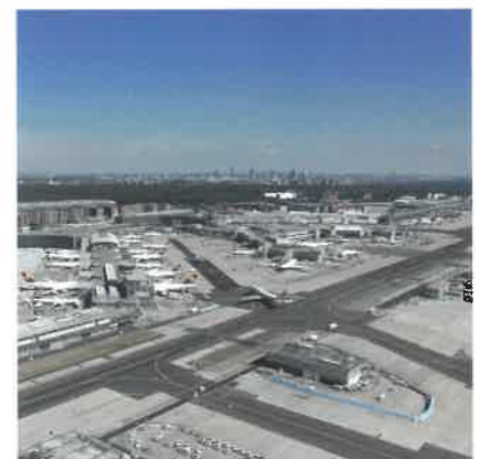
Sanierung am Flughafen Frankfurt am Main
