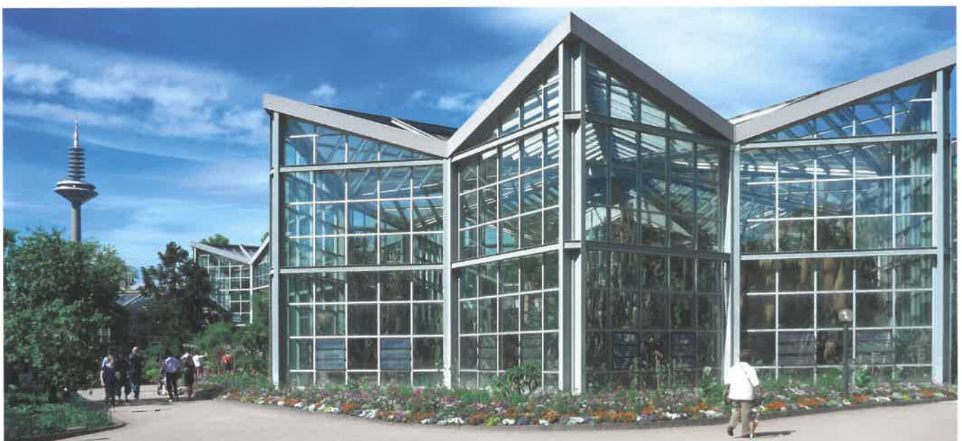
Sanierung des Tropicariums im Palmengarten, Frankfurt am Main
