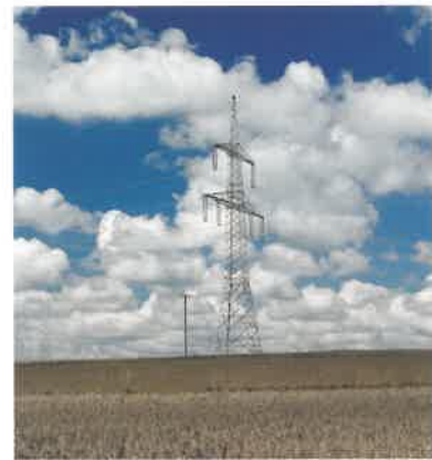
Ausbau des Energieversorgungsnetzes
