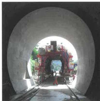
Neubau und Sanierung neuer und alter Bebenrothtunnel
