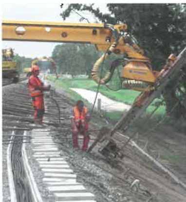
Ausbau Bahnstrecke, Ulm
